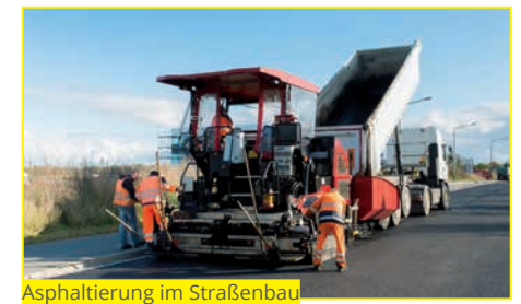
Asphaltierung im Straßenbau
