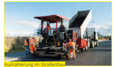
Asphaltierung im Straßenbau
