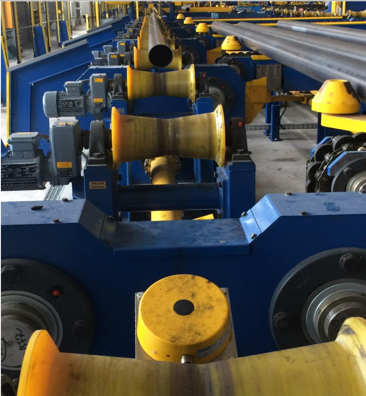
Proxitron Sensor unterhalb des Rollganges (Position 2)
