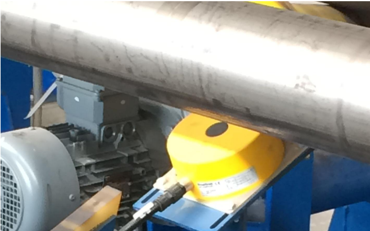
PROXITRON Sensor Unterhalb des Rollganges Position 1
